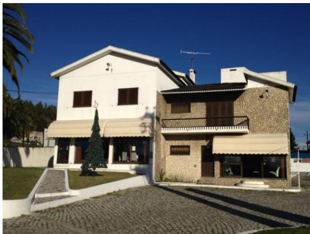
Figura 108 - Edifício de habitação correspondente ao receptor R9HI
