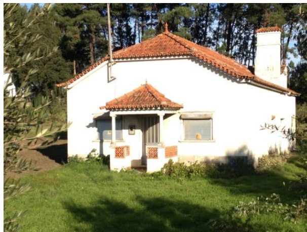
Figura 107 – Edifício de habitação correspondente ao receptor R9Hm
