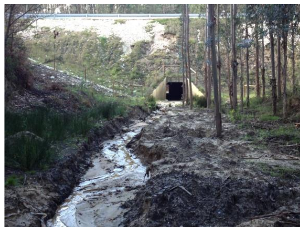
Figura 2 – Jusante da PH8.2 e das nascentes do Brejo
